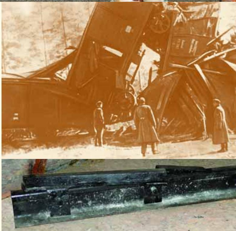
«Партизанский клин», он же «переводная стрелка». Выполнен по чертежам инструктора подрывного дела при штабе Минского партизанского соединения, бывшего инженера-железнодорожника, Т.Е. Шавгулидзе
