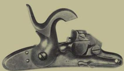
Капсюльный замок Августина. Вместо появившегося чуть позже колпачка применялась медная трубочка-капсюль, помещаемая в специальный вырез на полке замка
